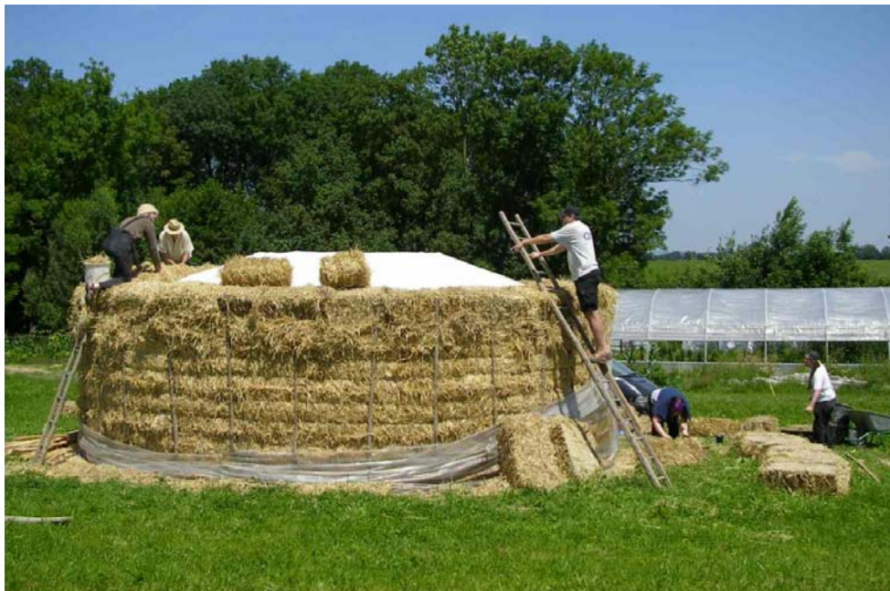
Abbildung 12: Eine von Claudius Kern geplante Strohjurte in Bau (Foto: C. Kern)
