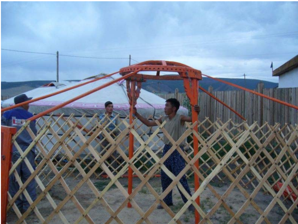
Abbildung 5: Aufbau einer Jurte. Ein Scherengitter bildet die Wand und die Stützpfosten tragen bereits die Krone. Auch die ersten Dachstreben sind angesteckt (Foto: H.-G. UNTERRAINER).
