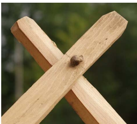
Abbildung 4: Original-mongolische Scherengitter-Verknüpfung aus Tierhaut (Foto: C. KERN).
